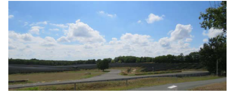
Parc photovoltaïque localisé à 260 m au nord-ouest de la zone d'étude
