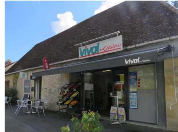
Bâtisse regroupant une épicerie de proximité (Vival), un bar et un bureau de tabac à Faux
