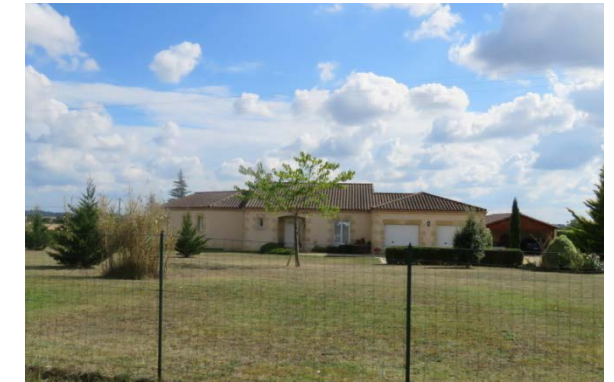
Construction récente à la façade enduite, à tuile canal, et dotée de chaînes d'angle
