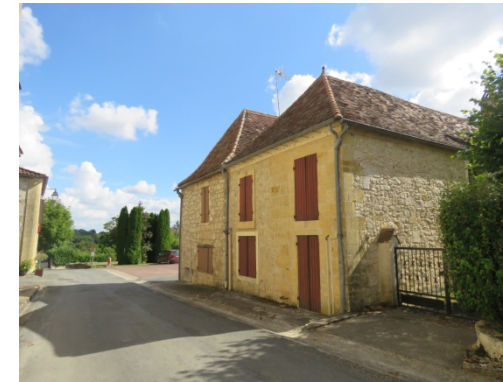
Toiture surmontée d'un épi de faîtage
